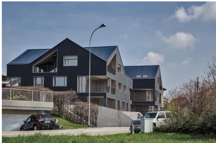
Bild 5: Einfamilienhaus mit kompletter PV-Fassade in Brütten
